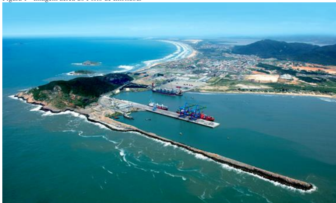
Figura 1 - Imagem aérea do Porto de Imbituba.
