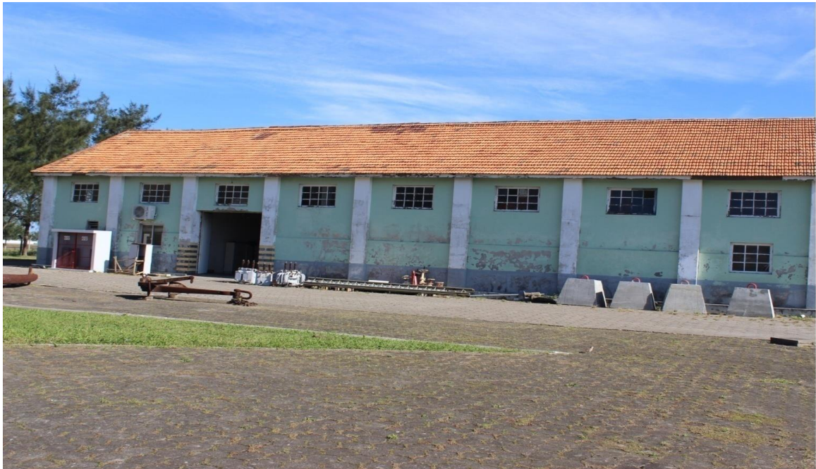
Figura 18 – Antigo prédio da manutenção elétrica
