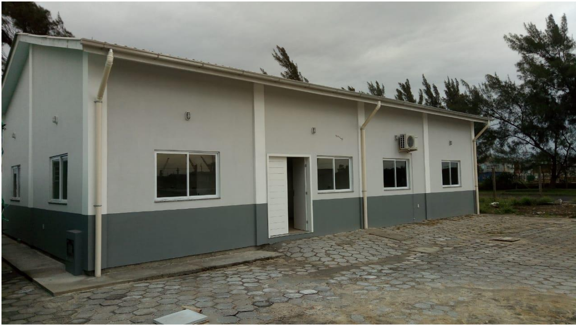
Figura 2 - Prédio da Manutenção Elétrica
